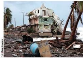
ARMERIA, Colima, ayer, afectado por lluvias.
