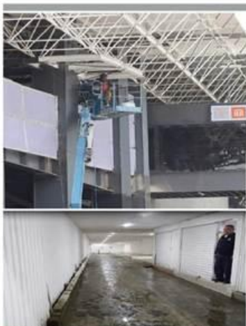
En bajopuentes y estaciones del Metro siguen las obras.
