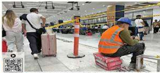
Los trabajos en el aeropuerto capitalino llevan un avance de entre 60 y 65 por ciento en su fase prioritaria.
